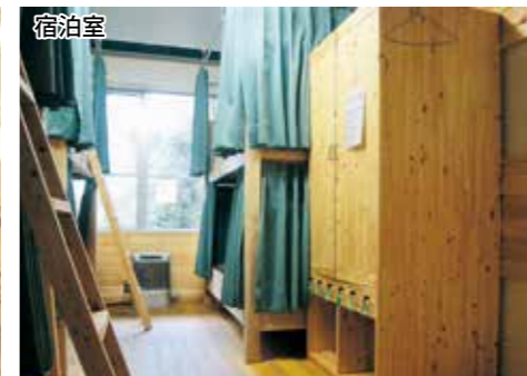
壁板に木曽ヒノキ、南部アカマツ、秋田スギ、青森ヒバ、琉球マツを使用
