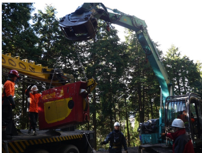
タワーヤーダの架設作業
