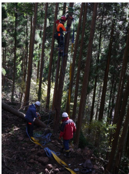
タワーヤーダの架設作業（先柱の設営）
